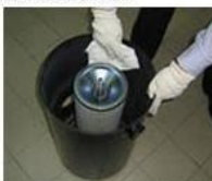
8. 清理空滤器内部，检查进气系统有无破损
